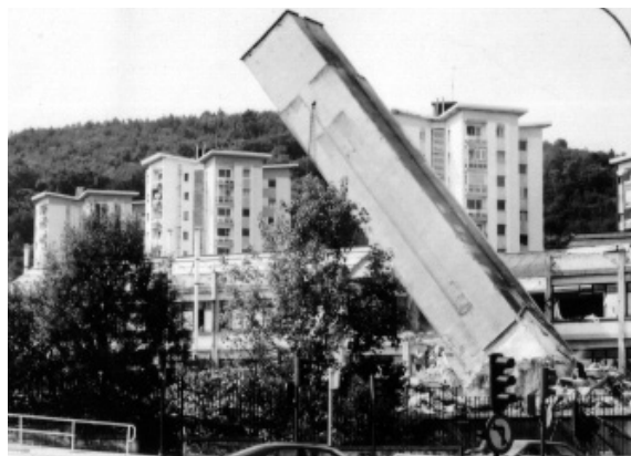
Derribo de la torre de Contadores
