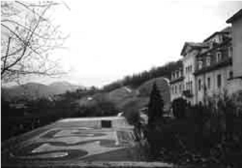
“Los Agustinos”: Patinaje pista eta dantzalekua izan, eta egun Zentax lasterketak egiten diren patioa; eta Urumeako autobiderako obra lanak Maite Albero (2005- 02- 12)
